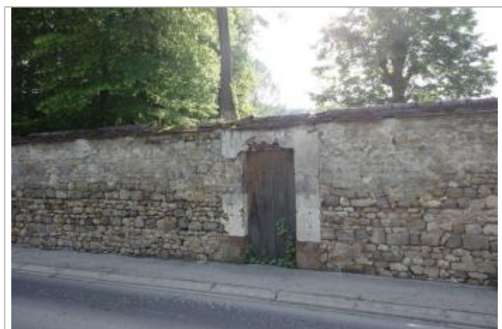
Vue de la laisse - Auteur : SPC SMYL
