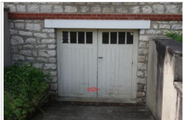
Vue de la laisse - Auteur : SPC SMYL
