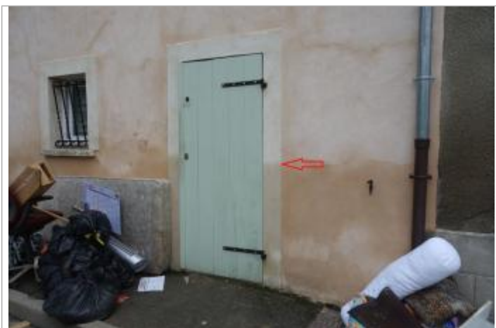
Vue de la laisse - Auteur : SPC SMYL
