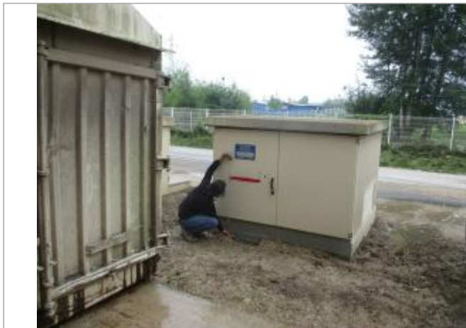
Vue du site - Auteur : SPC SMYL
