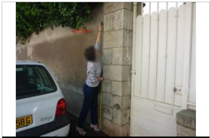
Vue de la laisse - Auteur : SPC SMYL
