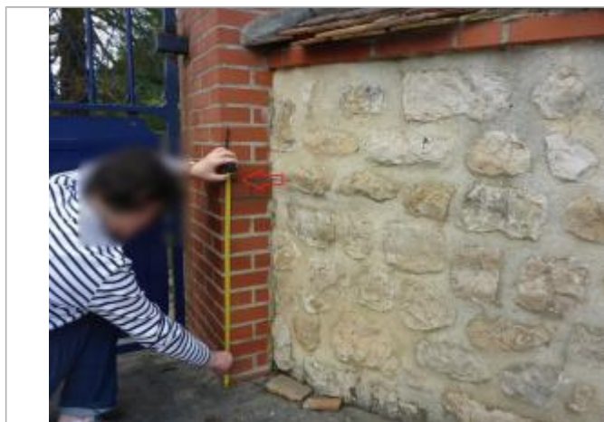
Vue de la laisse - Auteur : SPC SMYL
