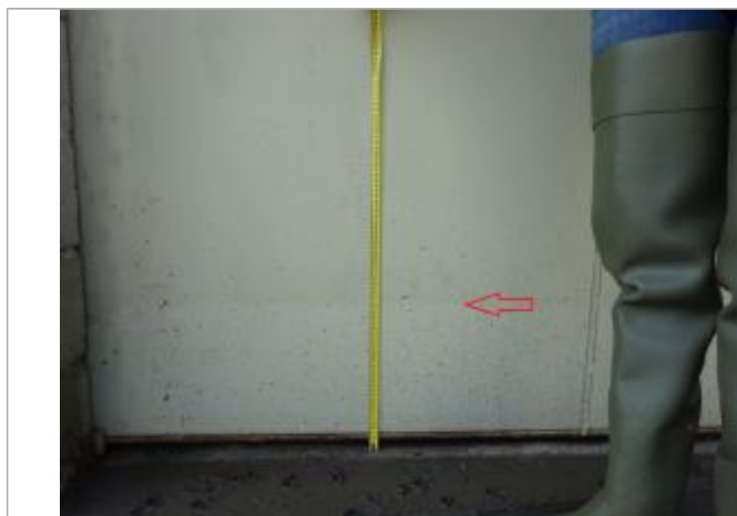
Vue de la laisse - Auteur : SPC SMYL
