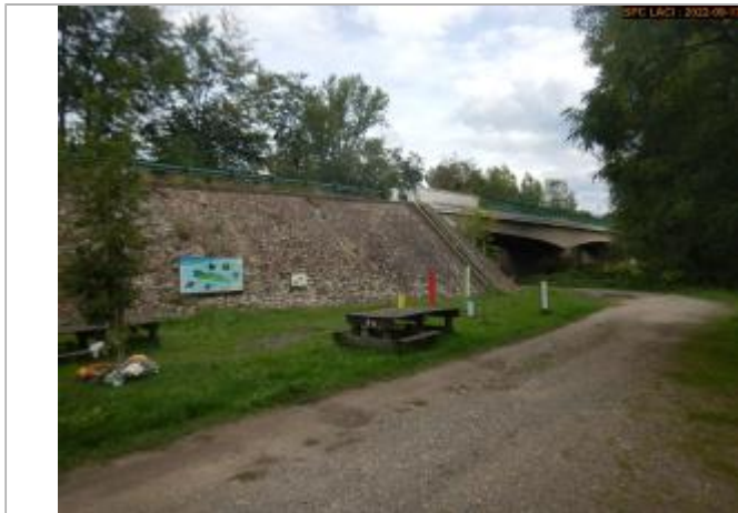
Vue du site éloignée
