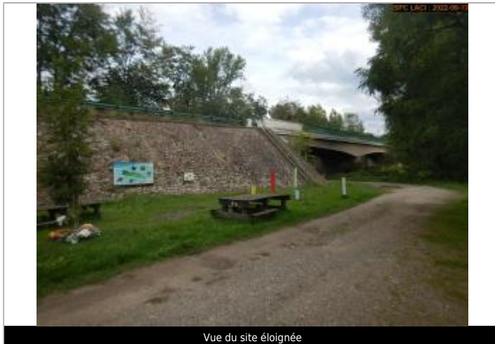
Vue du site éloignée
