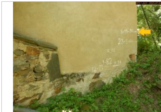
Vue du repère en 2023
