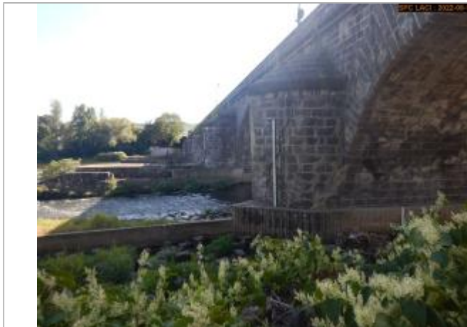
Vue du site éloignée
