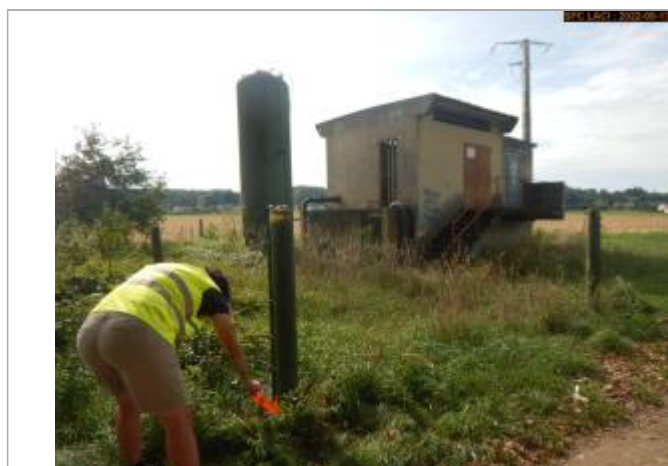
Vue du repère éloignée (poteau côté amont Allier)
