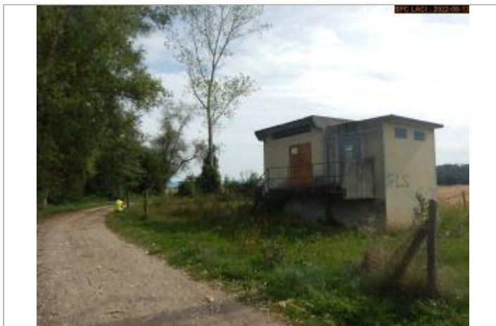
Vue du site éloignée
