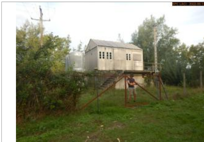
Vue du site éloignée (station pompage)
