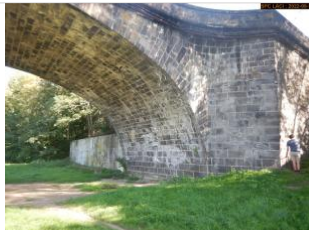
Vue du site éloignée
