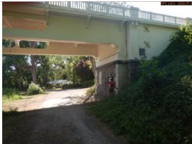
Vue du site éloignée
