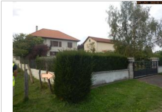
Vue du site éloignée
