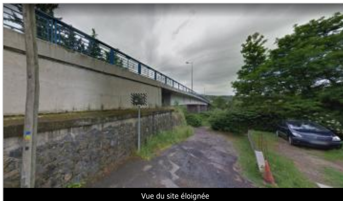
Vue du site éloignée
