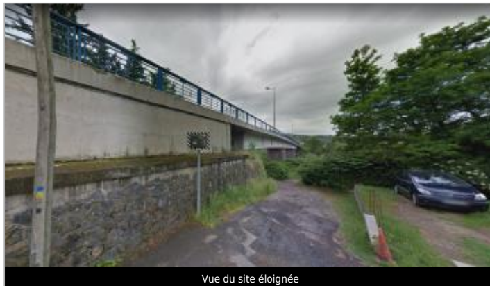
Vue du site éloignée
