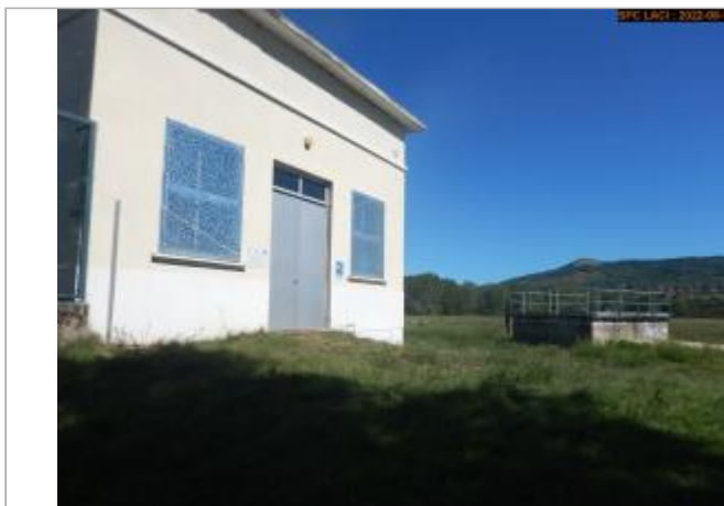
Vue du site éloignée
