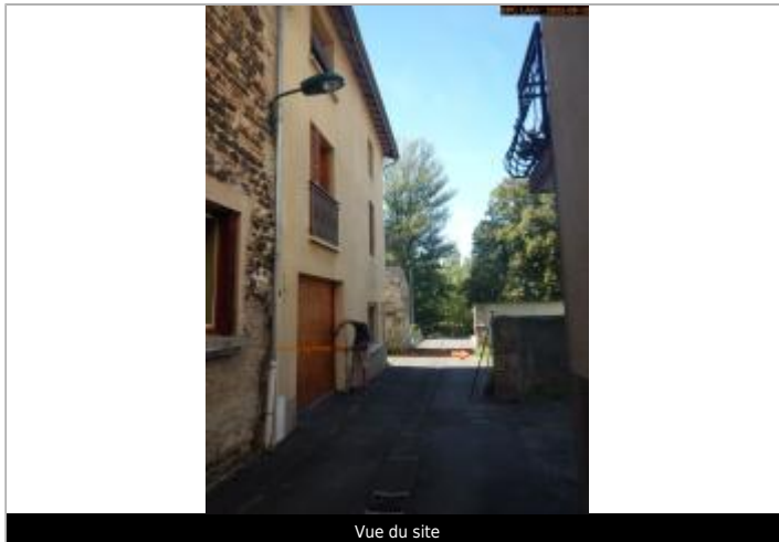
Vue du site
