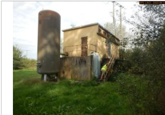
Vue du site éloignée (crue 12/2003)
