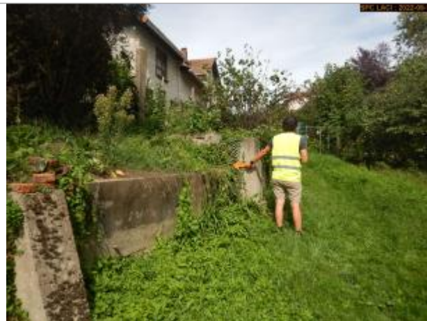
Vue du site éloignée
