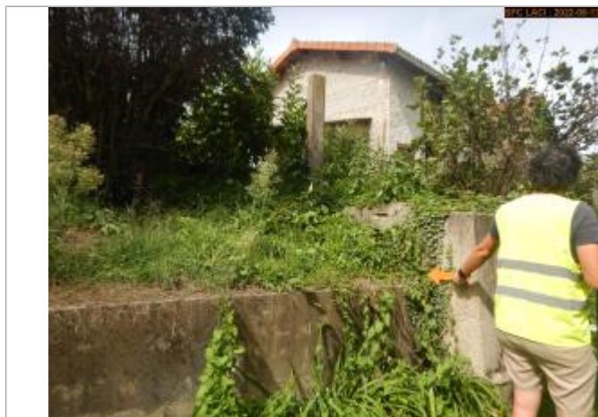
Vue du repère rapprochée
