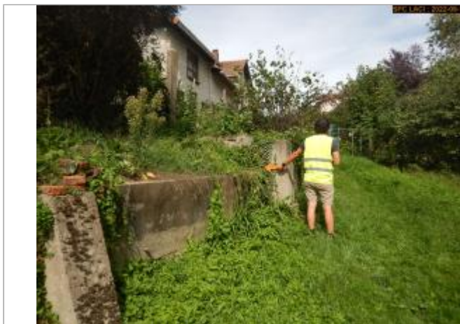
Vue du site éloignée
