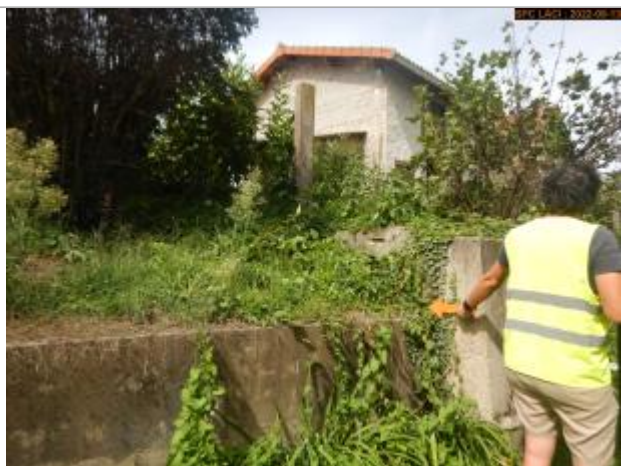
Vue du repère rapprochée
