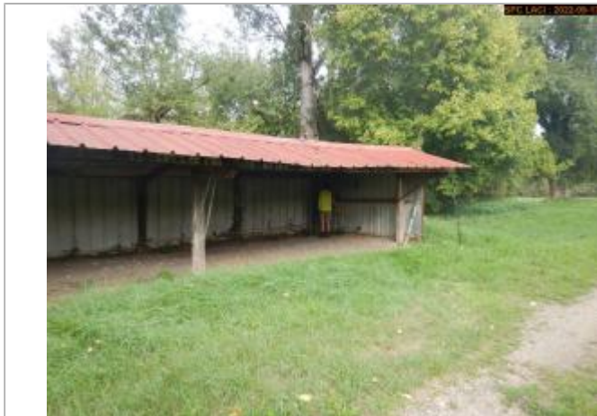
Vue du site éloignée
