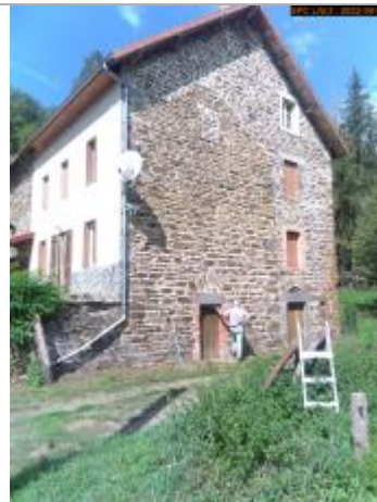
Vue du site éloignée
