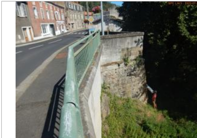
Vue du site éloignée
