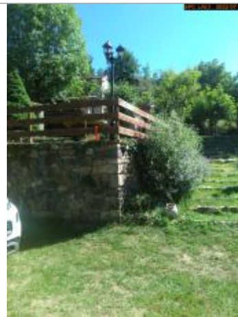
Vue du support éloignée (nouvelle référence)
