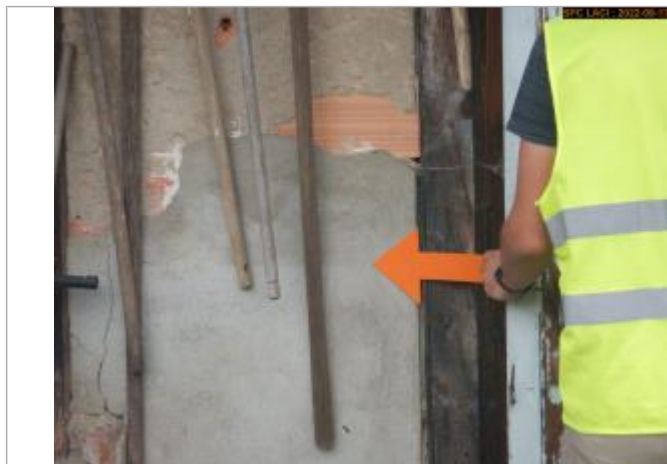
Vue du repère éloignée (porte)
