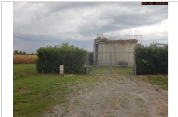
Vue du site éloignée
