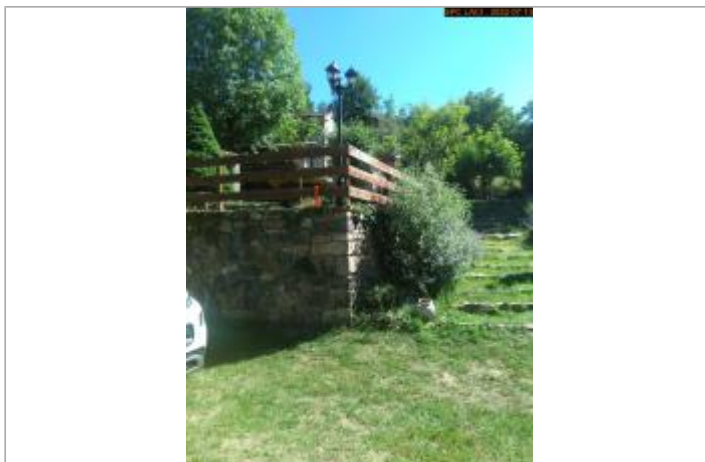
Vue du support éloignée (nouvelle référence)
