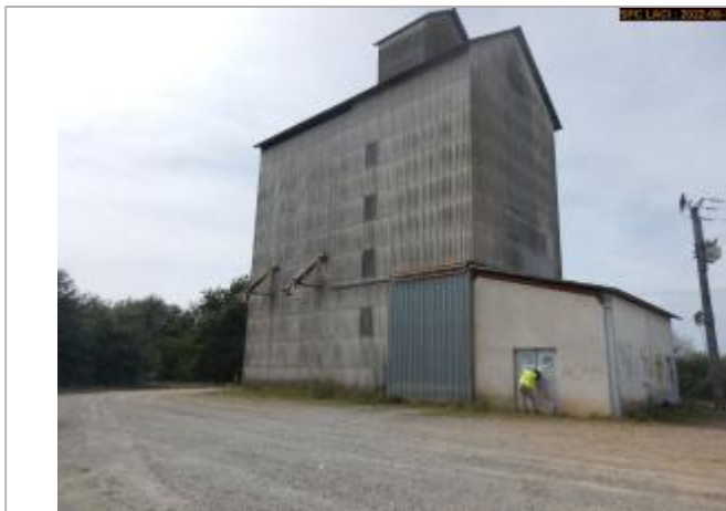
Vue du site éloignée
