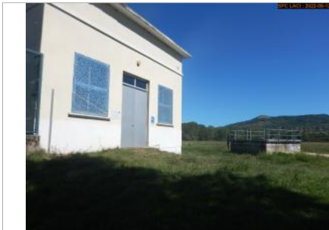
Vue du site éloignée
