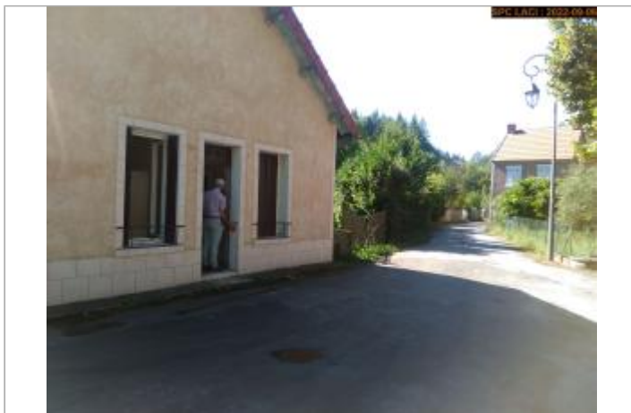
Vue du site éloignée
