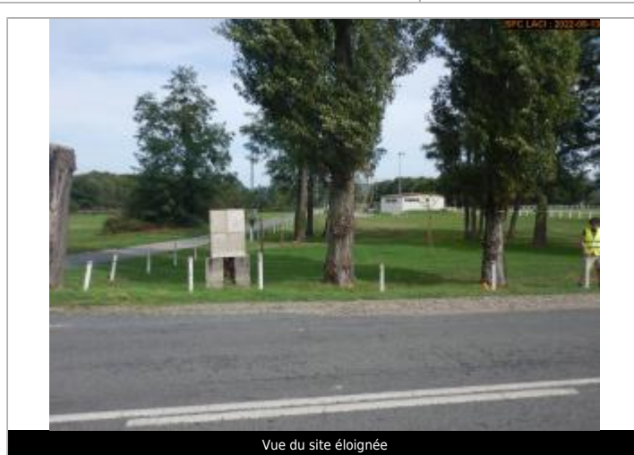
Vue du site éloignée
