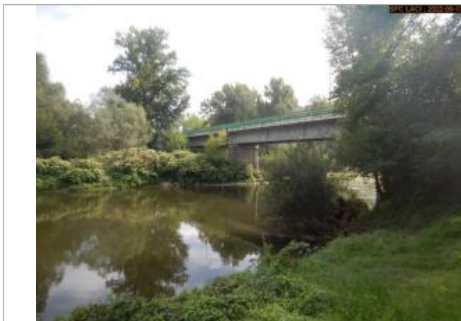
Vue du site éloignée
