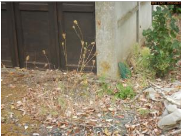
Vue du repère au pied du garrage (11/2008)
