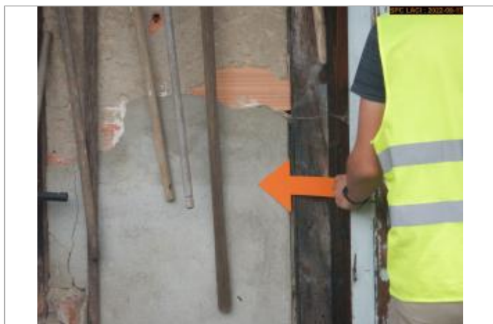
Vue du repère éloignée (porte)
