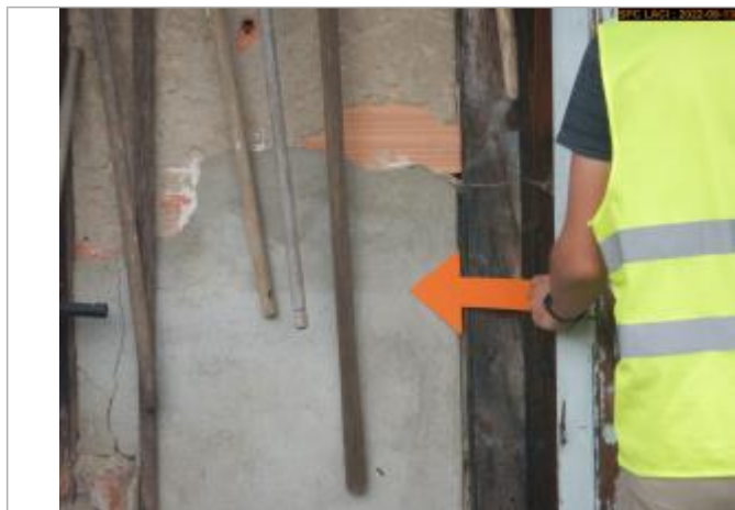
Vue du repère éloignée (porte)
