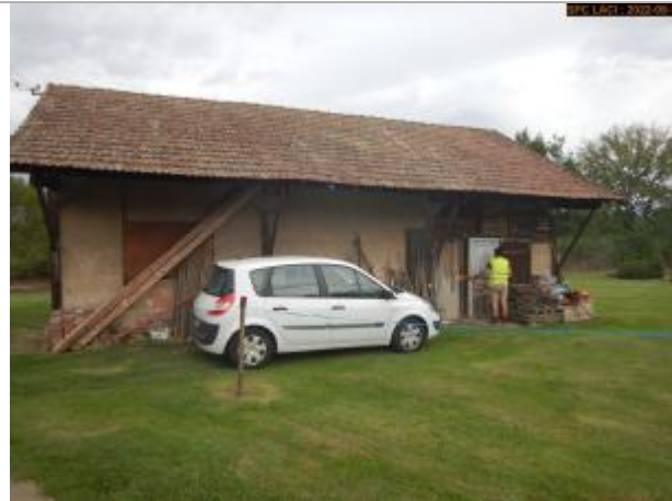
Vue du site éloignée
