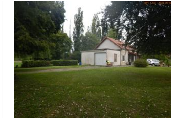
Vue du site éloignée
