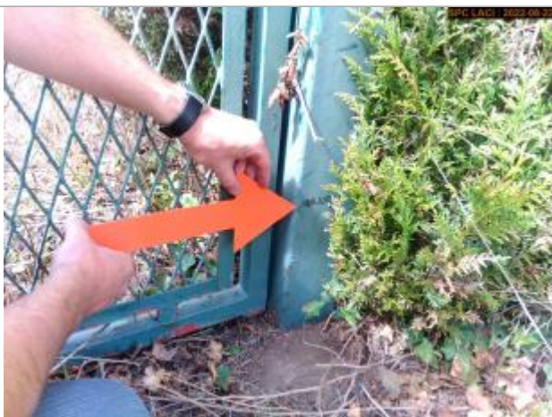
Vue du repère rapprochée
