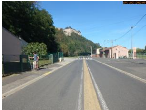
Vue du site éloignée
