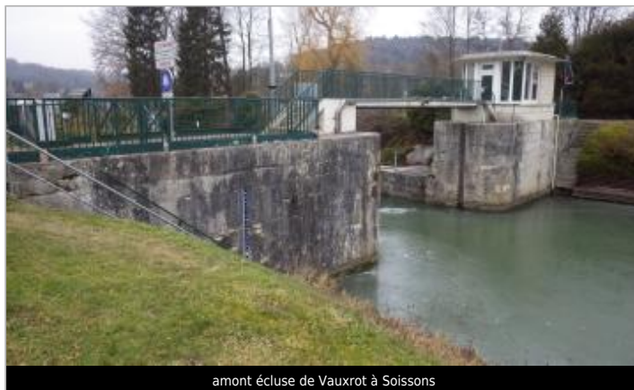
amont écluse de Vauxrot à Soissons
