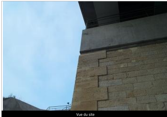
Vue du site
