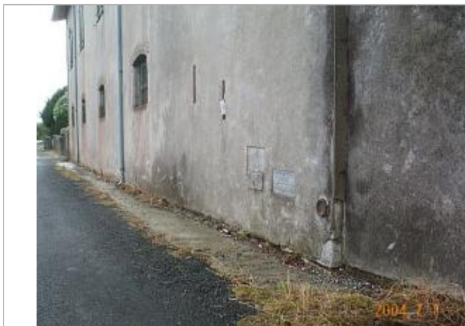
Vue du site
