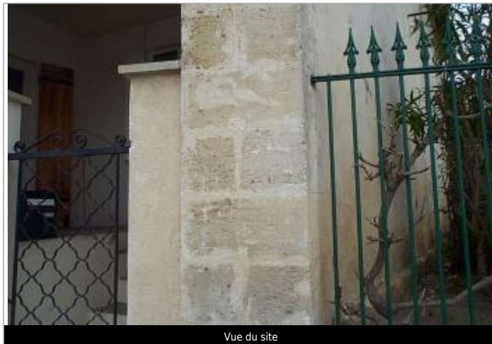
Vue du site
