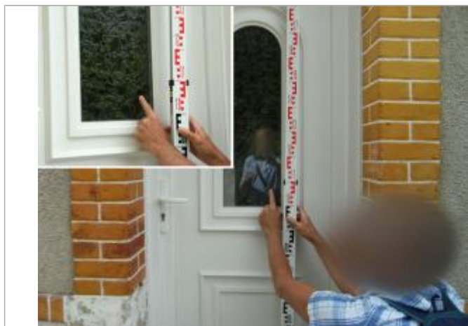
Détail du repère de la crue de juin 2016
