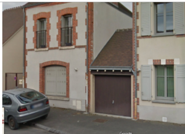
Vue d'ensemble du site (source : Google Street View, mai 2016)
