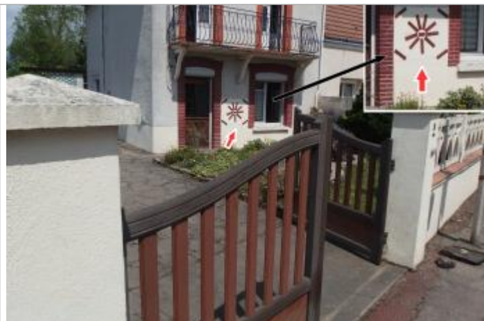
Site et détail du repère de la crue de 2016
