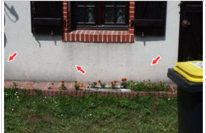
Site et repère de la crue de 2016
