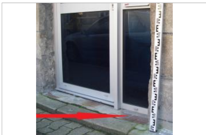
Seuil à l'entrée de l'agence - Photographie DHE 2015
