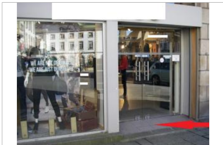
Seuil de la porte d'entrée du magasin - Photographie DHE 2015
